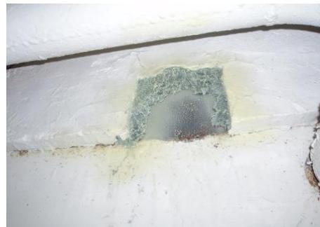
図 3.3 吹き付け表面がプラスター（漆喰のようなもの）で押さえられた写真（左）
