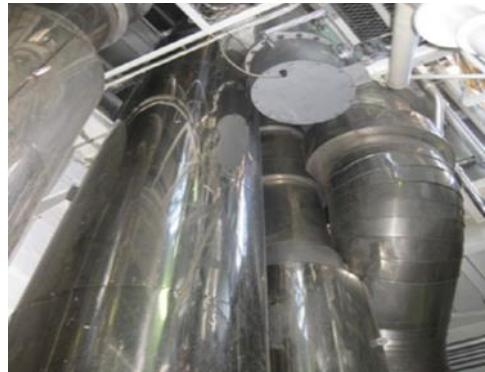
図 3.18-2 煙突内の排気管群
