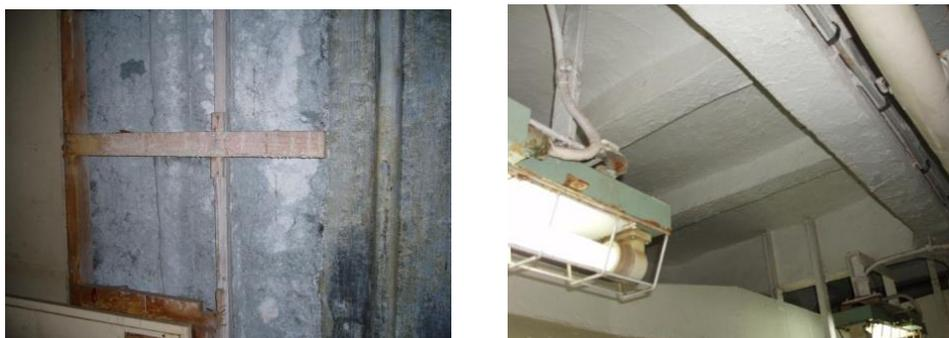
図 3.2 居住区壁裏の石綿含有吹付け材（左）天井に吹付けられた結露防止石綿材（右）
