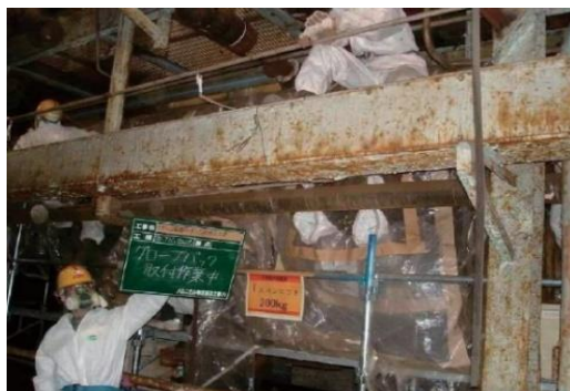
図4.8.8 特殊グローブバッグ取付作業中
