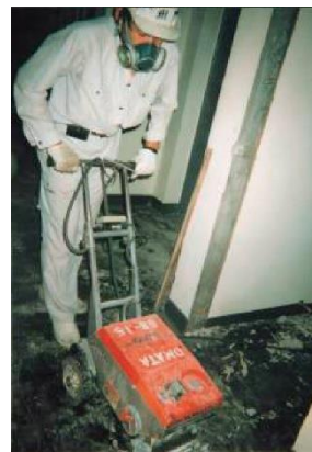
図4.10.4 石綿含有ビニル タイルの除去例
