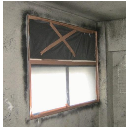
参考図 3.7 窓、換気口の隔離例
