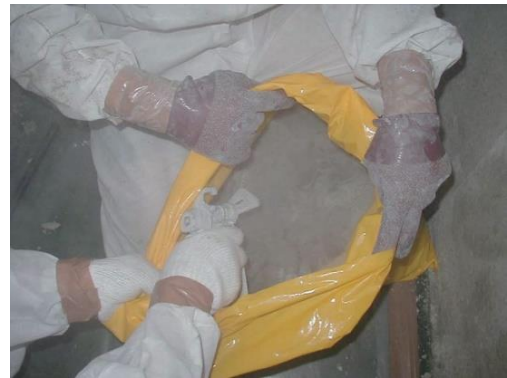
参考図3.46 袋詰めした石綿廃棄物への粉じん飛散防止処理剤を散布
