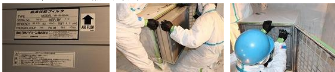
参考図 3.56 フィルタの取り付け
