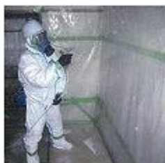
②隔離シートへの散布
