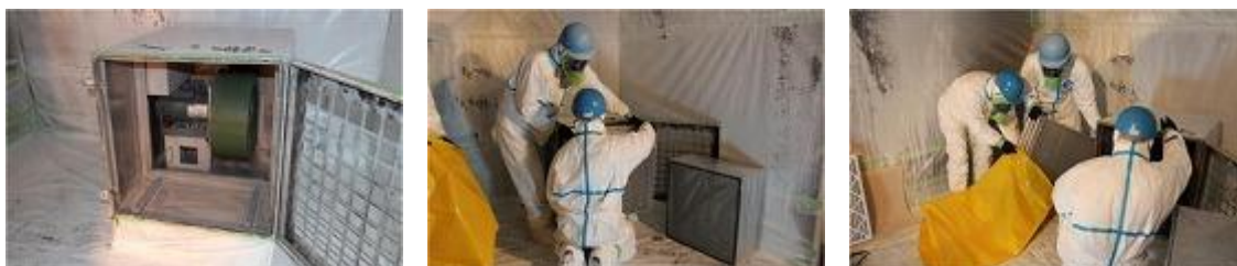
参考図 3.55 HEPAフィルタの交換
