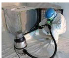
参考図 3.53 HEPAフィルタ等の清掃
