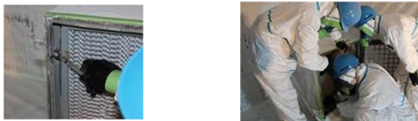
参考図 3.54 HEPAフィルタの留め付の緩み点検
