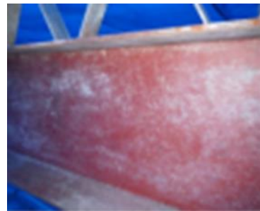
参考図3.40 再付着した石綿の例
