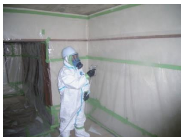
参考図3.49 隔離シートへの粉じん飛散防止
