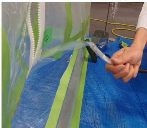
参考図4.10 スモークテスターによる確認
