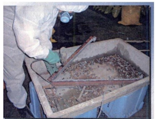
図4.10.8 掻き落とし除去作業の例
