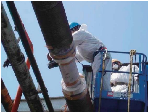
図4.8.4 切断箇所の除去と養生
