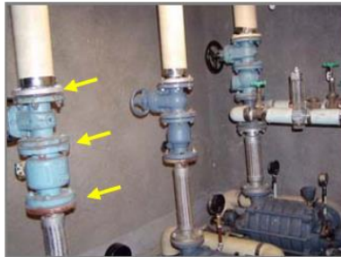
バルブ継ぎ手部などへのパッキング・ガスケット (継ぎ目に挟まっていますので写真では見え ていません)
