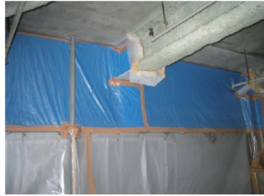
参考図 3.5 壁面の隔離例（作業場内側）
