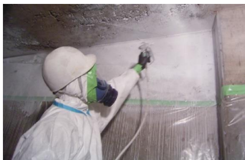
図 3.43 除去した後の下地面への粉じん飛散防止剤の散布
