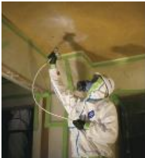
参考図3.39 粉じん飛散抑制剤の散布による湿潤化
