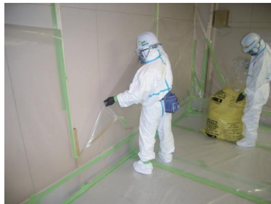
参考図3.61 隔離シートの撤去
