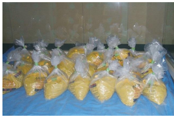
参考図3.48 除去した石綿廃棄物の一時保管
