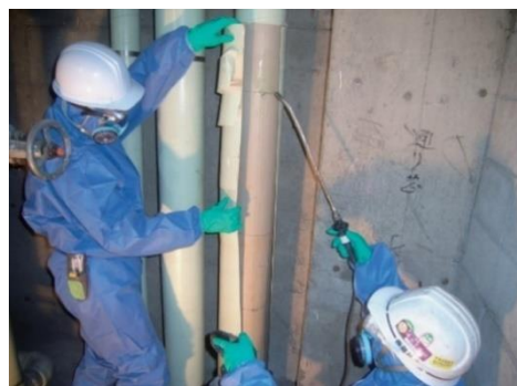
図4.7.2 保温材の取外し
