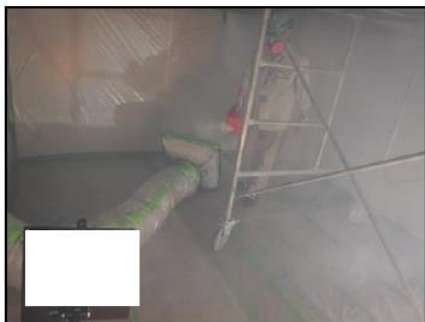
参考図 4.8 スモークマシンを使用した空気の流れの確認（集じん・排気装置設置時）
