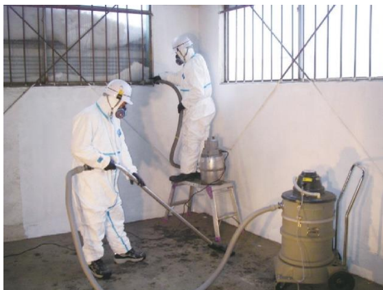
参考図3.62 高性能真空掃除機を用いた作業場内の仕上げ清掃
