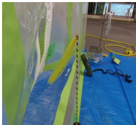
参考図4.11 吹き流しによる確認
