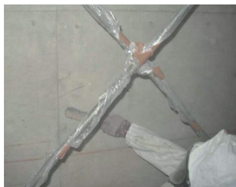
参考図3.42ワイヤブラシを用いた擦り落とし作業
