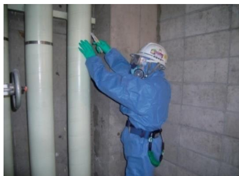
図4.7.1 保温材被覆撤去
