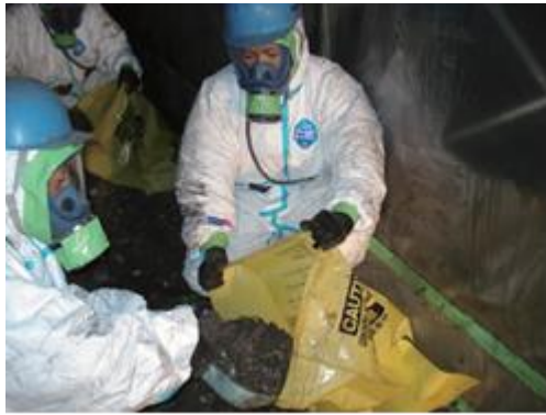
参考図3.45 除去した石綿廃棄物の袋詰め (一重目)
