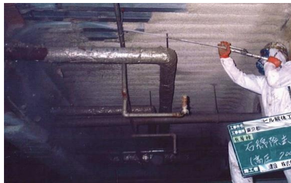
参考図 3.35 ウォータジェット工法の例
