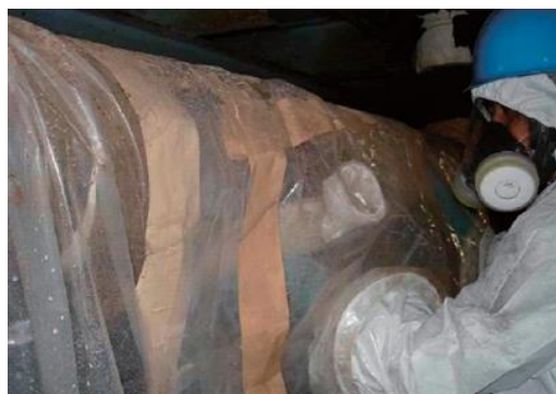
図4.8.10 石綿除去作業中2
