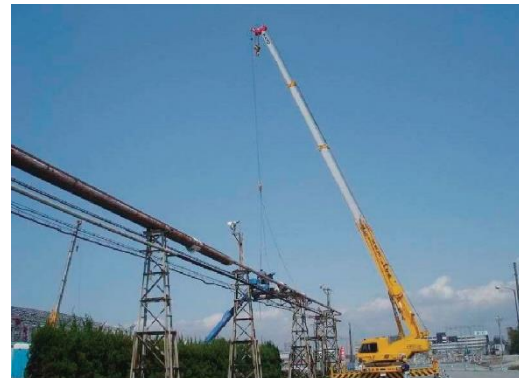
図4.8.5 配管吊り下ろし
