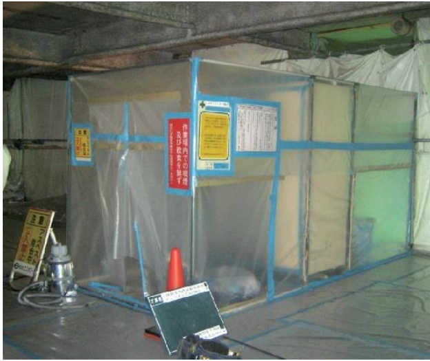
参考図 3.9 セキュリティゾーン外観
