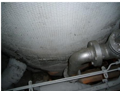
図 2-4 タンクの保温板。保温板の表面にアスベストクロスを貼り付けて金網で補強（左）、右はブリキ板で補強
