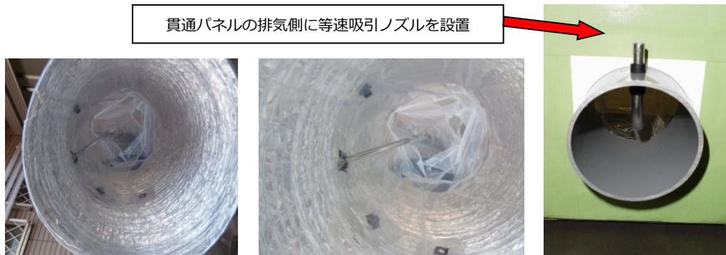
参考図 4.17 等速吸引ノズルを使用した場合の排気ダクト内の測定例
