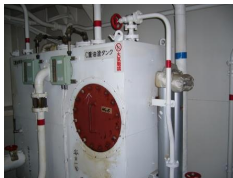
図 2-4 タンクの保温板。保温板の表面にアスベストクロスを貼り付けて金網で補強（左）、右はブリキ板で補強
