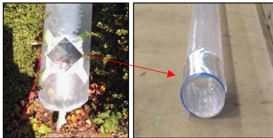
(x) (o) ビニールダクトの先端部分を環状の支え（アルミ製ダクト）を重ねて使用した例
