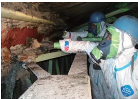
参考図3.41 手工具（ヘラ）を使用した石綿含有吹付け材の除去作業（ブラッシング）
