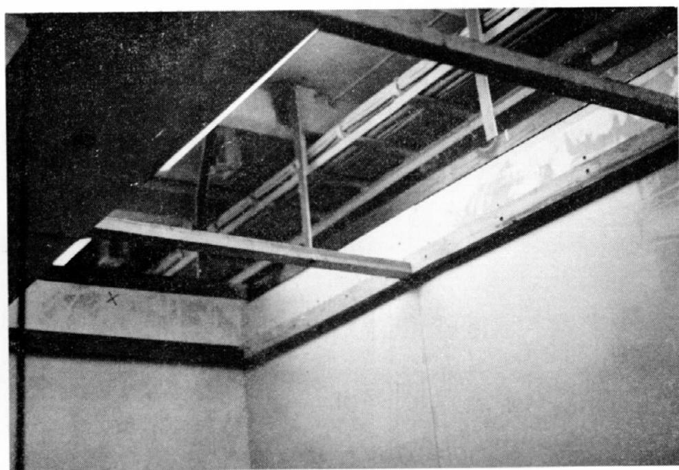
写真 4.1 (d) 試作船室の工事写真（天井根太取付け）
