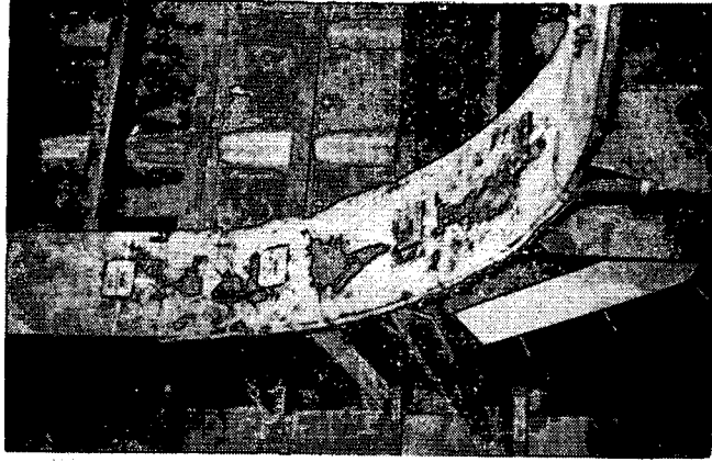
写真3 No.2 Ballast Water Tank 内計測位置
